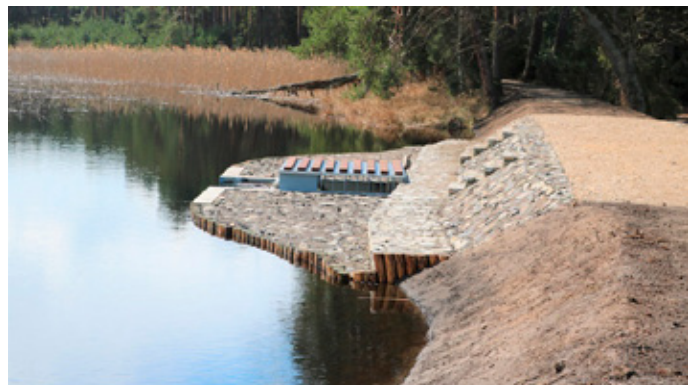
Nowe urządzenie piętrząco-upustowe tzw.mnich
