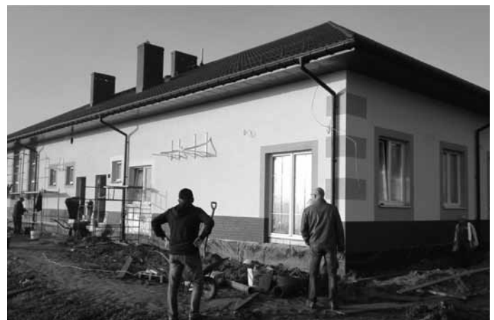
Powstaje budynek wielofunkcyjny w Sadowie.
