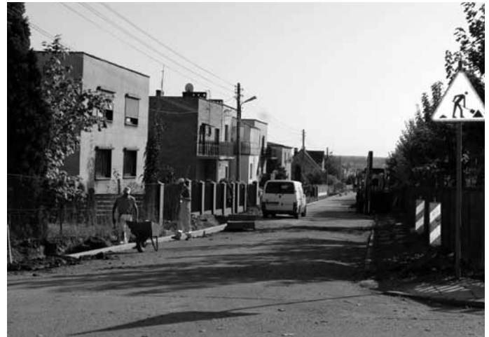
Ulica Burzyńskiego w Koszęcinie w budowie.
