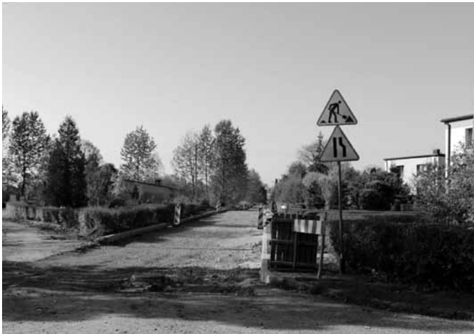
Ulica Bema w Koszęcinie w budowie.
