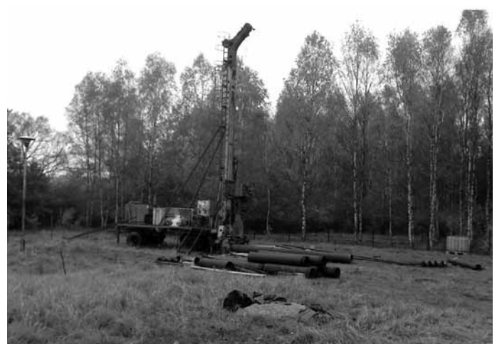
W Bruśku powstało nowe ujęcie wody.
