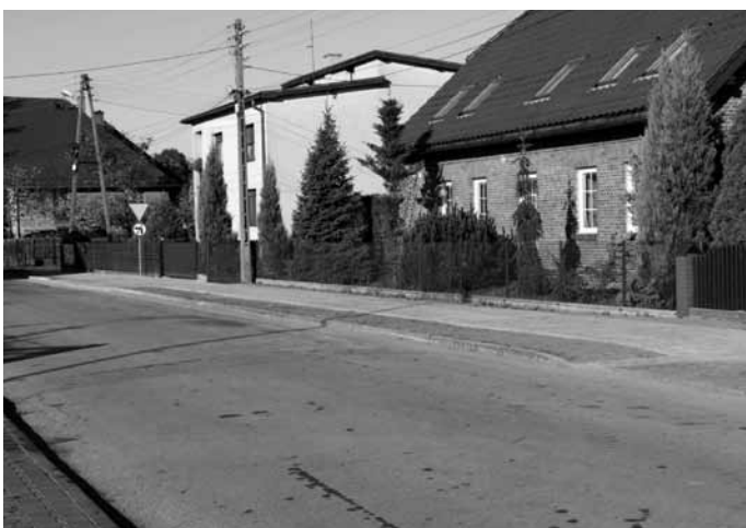
Budowa chodnika przy ul. Łazowskiej.
